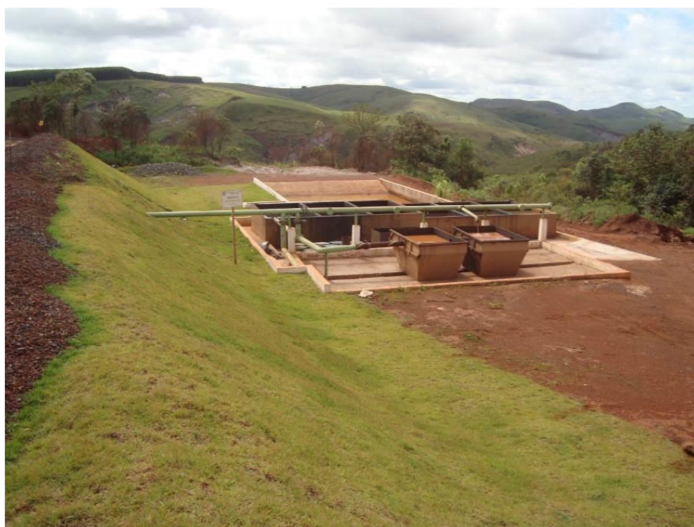
Sistema separador de água e óleo.
