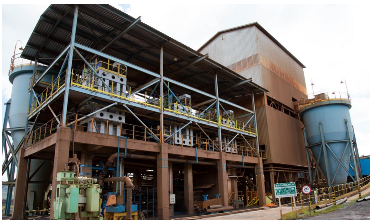
Concentradores Magnéticos e Prédio de Espirais que compõe a concentração de sinter feed. A direita observa-se o espessador de coluna EP-01.
