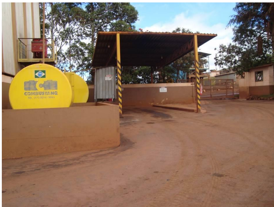
Posto de abastecimento, observando-se os tanques com a devida caixa de proteção.
