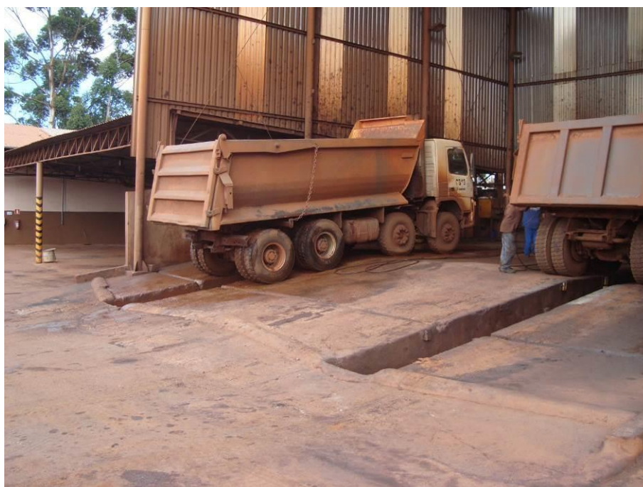
Rampa para lavação de veículos cujos efluentes oleosos são direcionados para caixa separadora de água e óleo.
